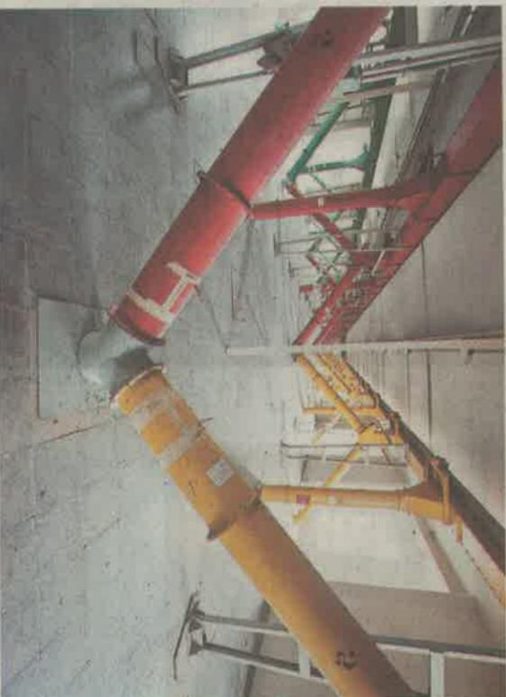
Planta superior de las calderas, que se llenaban a través de tuberías diferenciadas por colores.
