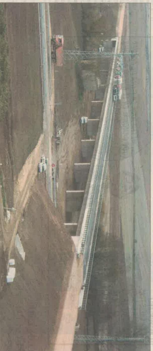
Prueba de carga en un viaducto sobre el río Hormazueta para la línea de Alta Velocidad a Burgos. / ADIF
