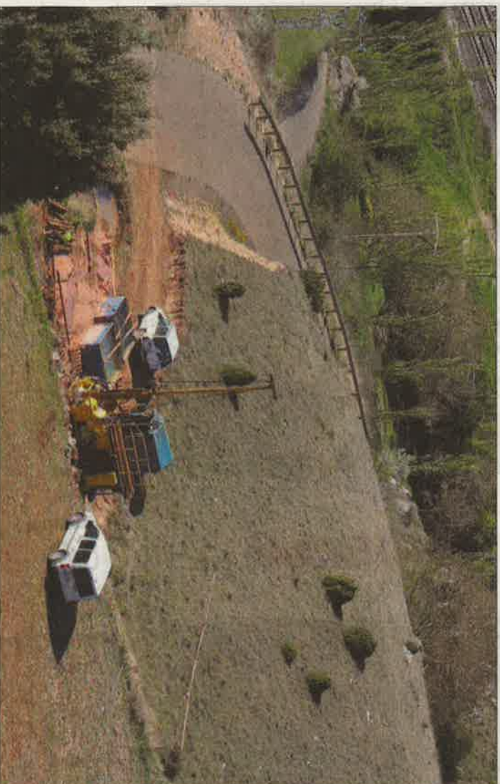
Los técnicos realizaron hace seis años cuatro sondeos para conocer la geología del paso del túnel. 6, 6.
